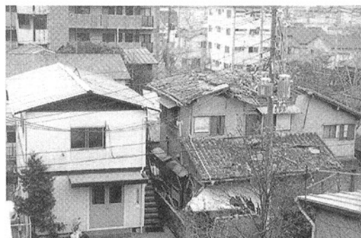
図 1 阪神大震災による家屋の被害状況
